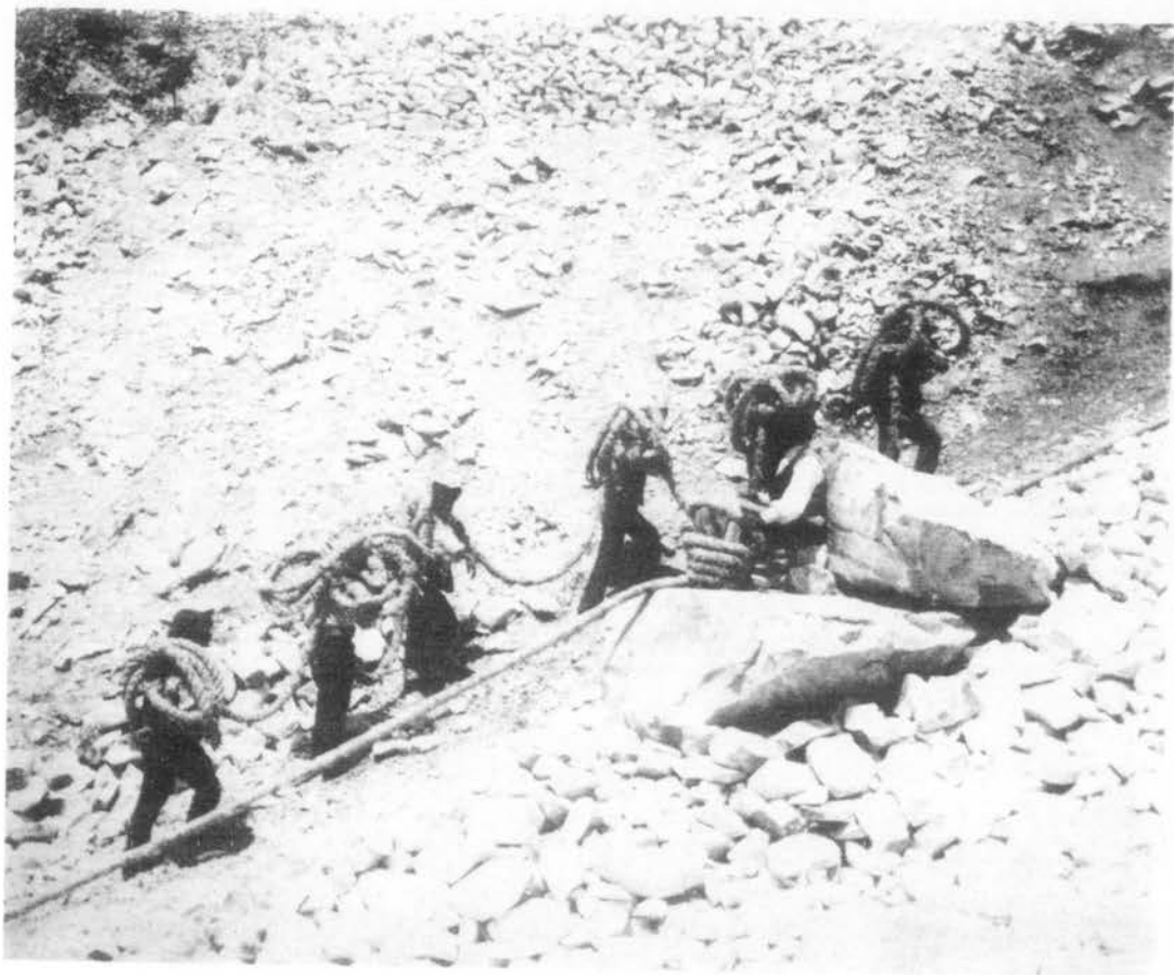
Plate 11. Men carrying the ropes for the lizza . (photo by Ilario Bessi, in Barratta, L'Ultimo dei Lizzatori , 1988).
